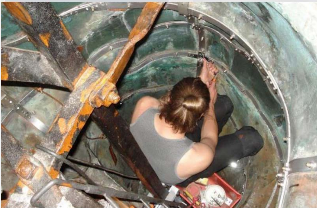
Kassel, Hercule, lucrare din cupru 1717, vedere de interior.
